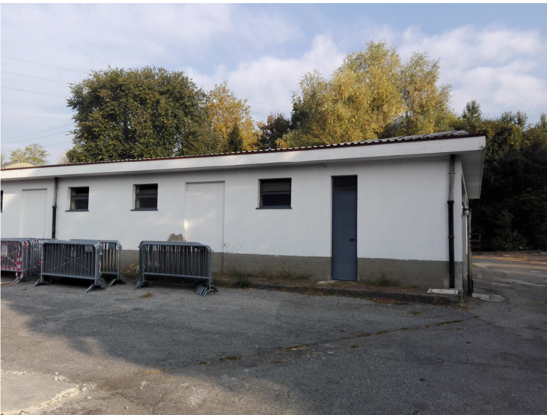
Fronte posteriore con nicchia dove deve essere aperta la nuova porta
